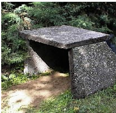
Betonplatten 50x50 cm vor Eingang
